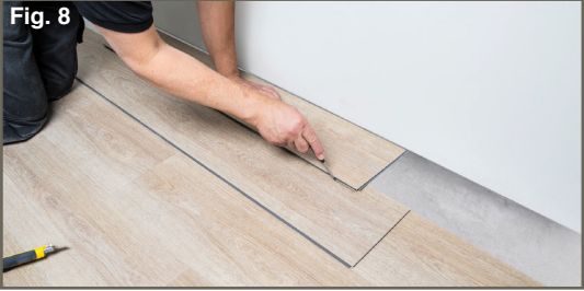
FIGURE 8 : Pour poser la dernière rangée de panneaux, vous devrez généralement en réduire la largeur.
