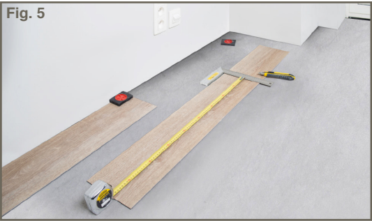
FIGURE 5 : Pour la dernière pièce, mesurez la dernière planche de telle sorte que l'espace de dilatation requis soit maintenu. Découpez la partie marquée et connectez l'extrémité du panneau de la même manière que les panneaux précédents.
