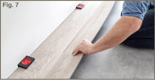
FIGURE 7 : Il est possible que certains panneaux doivent être doucement frappés au marteau pour que le joint se referme. Dans ce cas, utilisez une cale de frappe.
